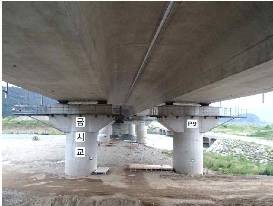
PSC BOX 외부 전경
